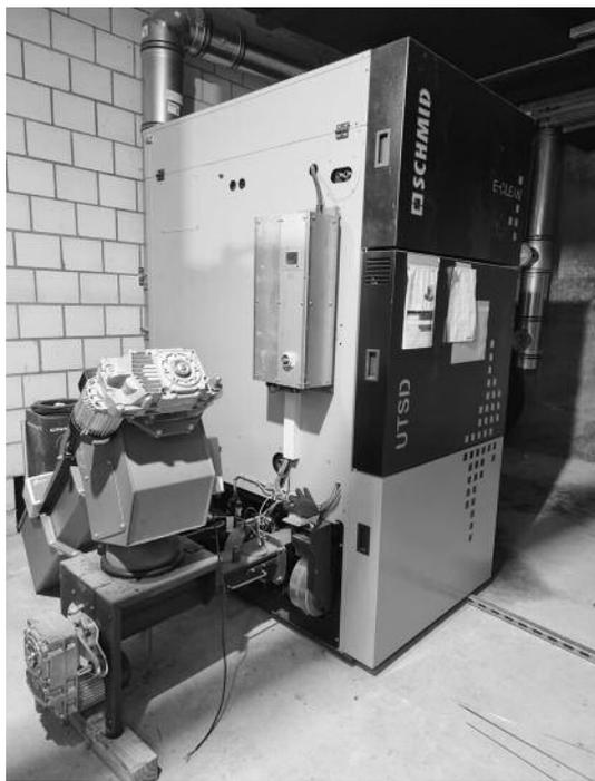
▲ Die neue Pelletheizung steht im «Maison Capitol». Links im Bild die automatische Einfüllung. Die Aufnahme stammt von Anfang Oktober 2021, die Heizung ist noch nicht angeschlossen.
